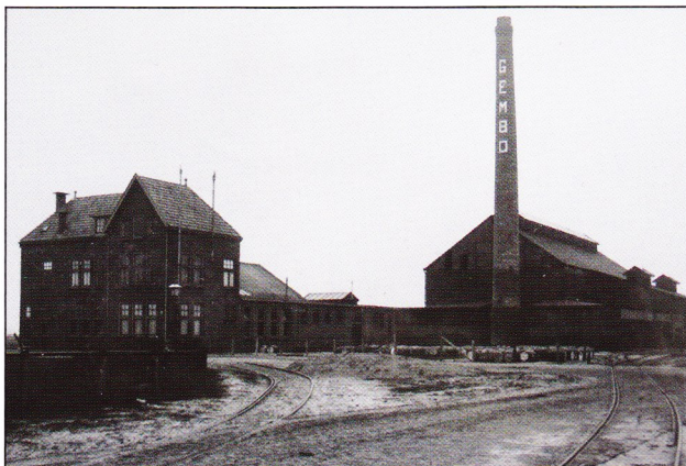
Vanaf boven met de wijzers van de klok mee: Gembo westzijde; jaren 1920. Rechts de tramaansluiting. Foto: archief Gembo.
