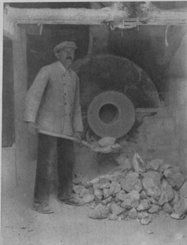
Links: in de kalkmolen wordt de kalk tot een meel-fijn poeder verwerkt.
