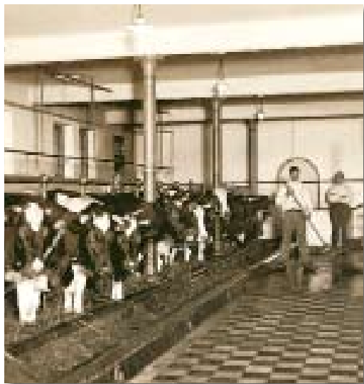
Het betegelde middenpad, waarop na het melken het voer voor de koeien werd gestort
